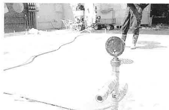
写真3 消臭剤の注入
