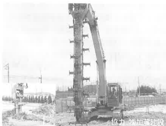
写真2 重機を用いた薬剤混合・攪拌工法の例
