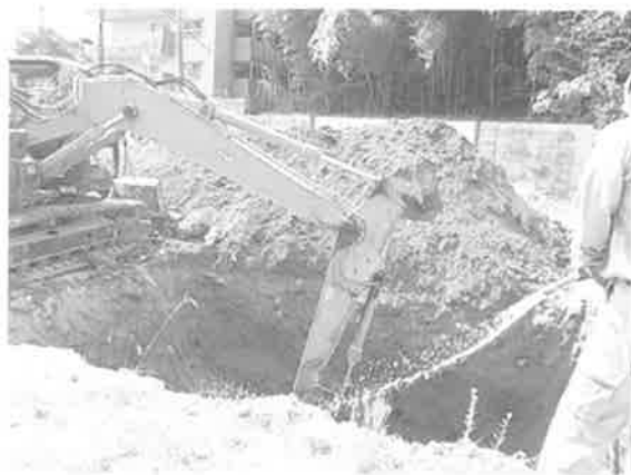
写真2 重機を用いた薬剤混合・攪拌工法の例
