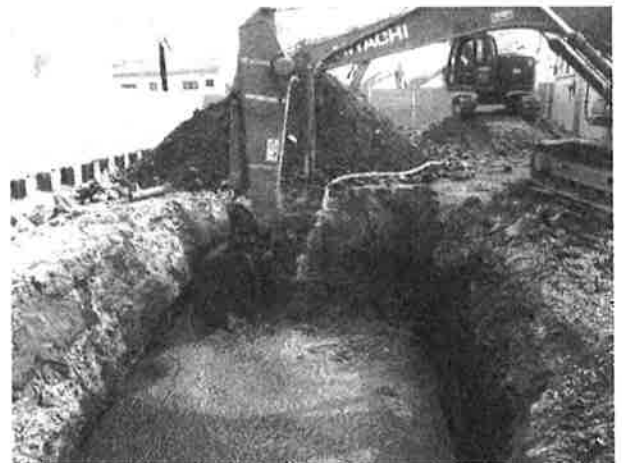
写真-1 バックホウによるフェントン反応剤攪拌混合
