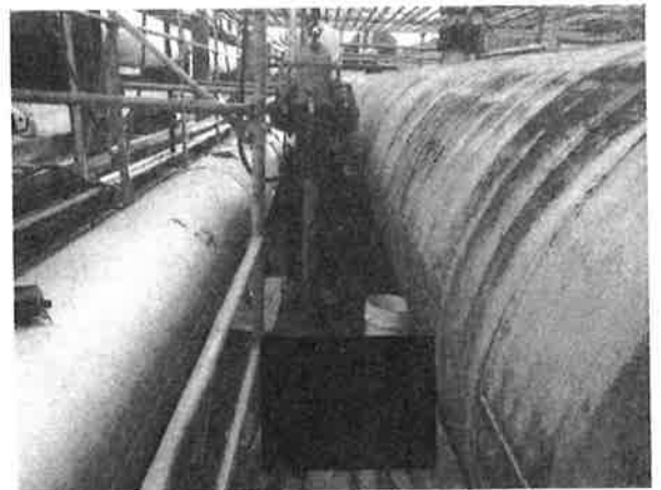
写真-6 狭い敷地内での施工状況
