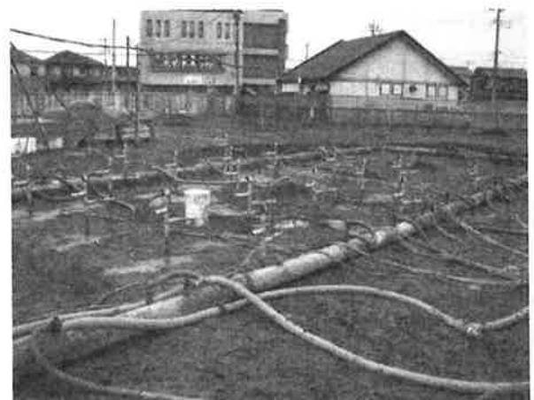
写真-7 フルアップポイント工法 施工状況
