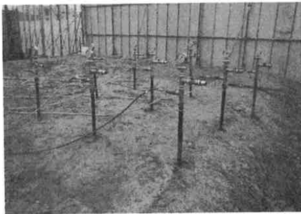
写真-5 フェントン反応剤注入状況
