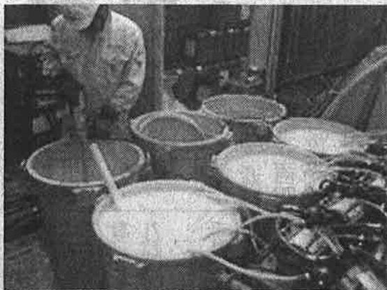
施工現場での希釈作業
