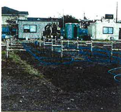
工場跡地の土壌を化学酸化によって浄化する作業の様子
