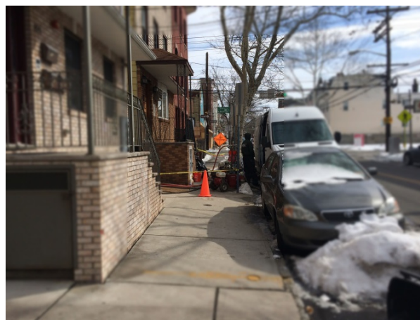
写真1 歩道上でのフェントン注入現場
